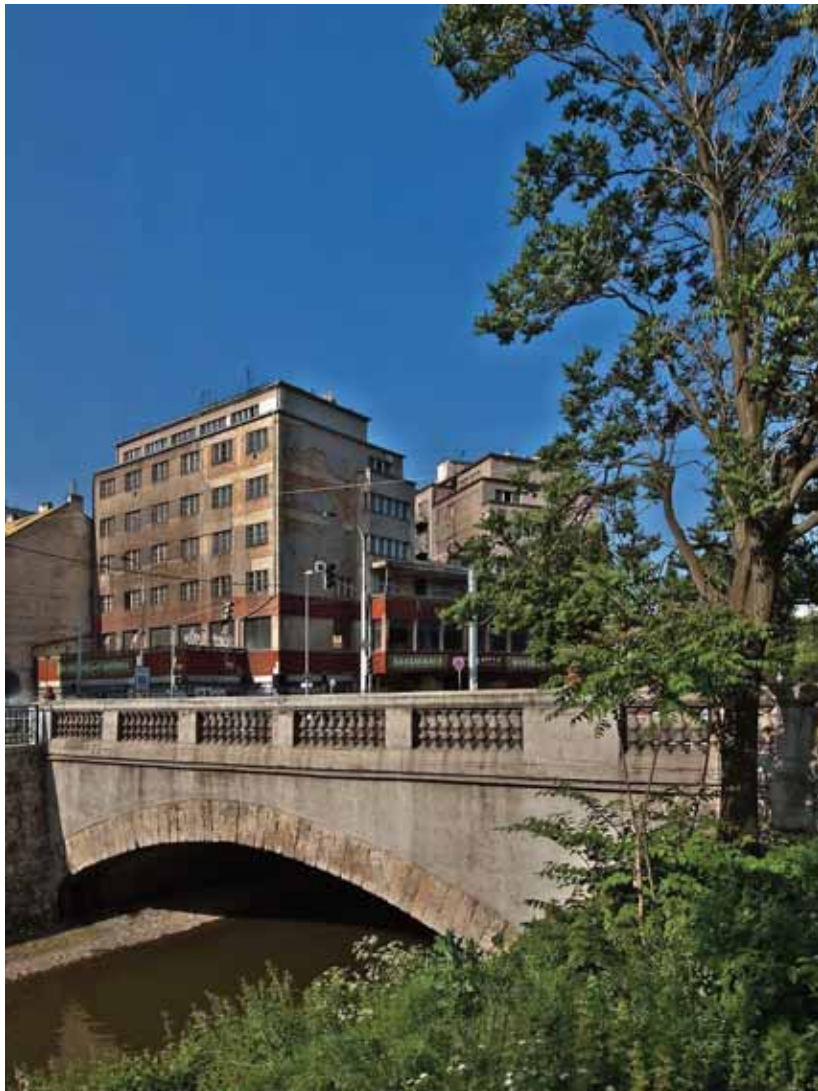
1. betonový most v Čechách, přes Rokytku
