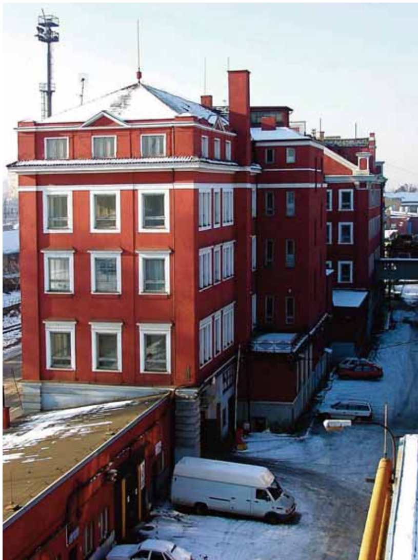
ČKD Lokomotivka (Českomoravské strojírny) před demolicí, r. 2002
