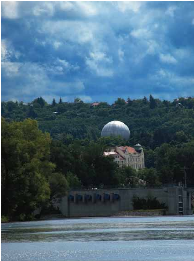
Libeňská plynárna, v popředí protipovodňová vrata na Rokytce
